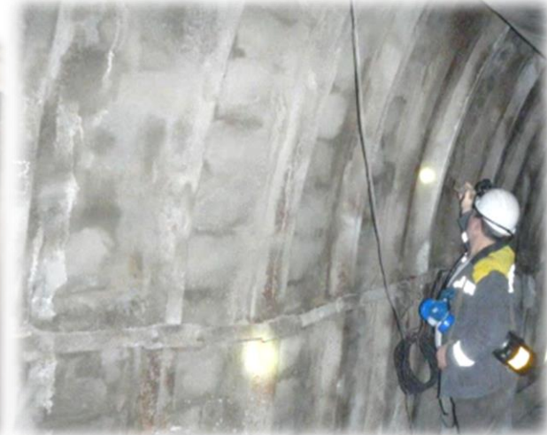
Якість поверхні виробки після торкретування
