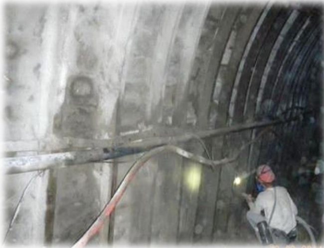
Нанесення торкрет-бетонної суміші на стіни виробки
