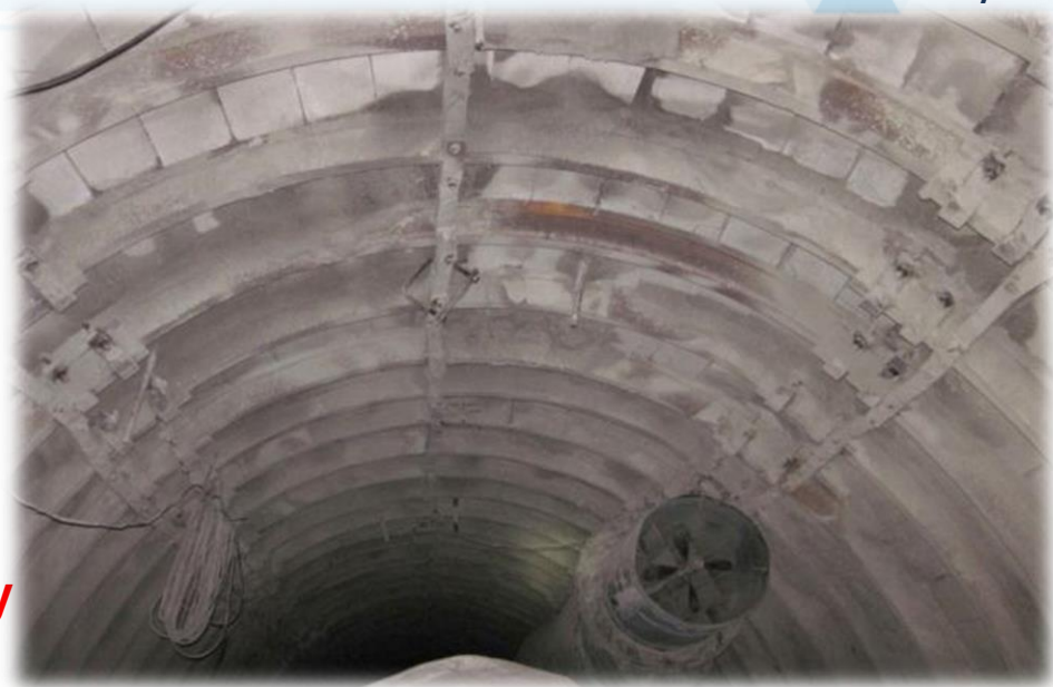
Вигляд виробки після проведення всіх заходів зі зміцнення масиву
