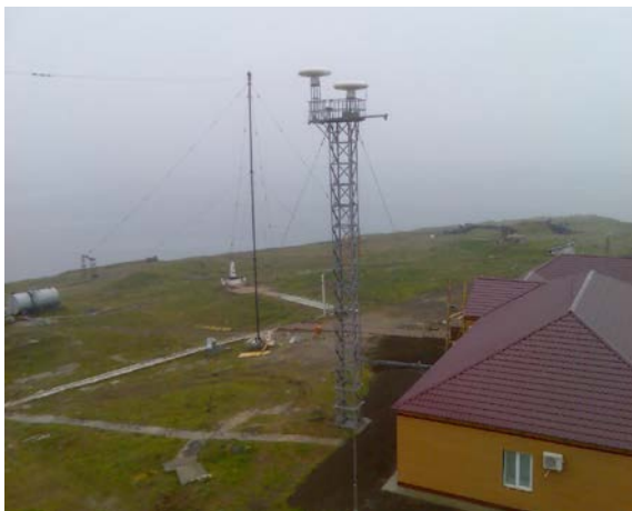
Рис.11. РЛС «Буревісник-4» на посту спостереження остров Змийний Одеського загону , звідки дані про стан надводної обстановки в зоні морського кордону передаються в систему «ГАРТ-12» Державної прикордонної служби України.
