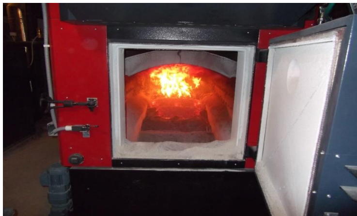
Вигляд на топку з відкритими дверцятами
