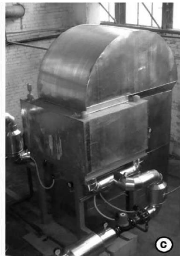
Теплообмінники – утилізатори з частково оребрених плоскоовальних труб тепловою потужністю : а - 51 кВт; б – 335 кВт; с – 490 кВт; d - 1400 кВт
